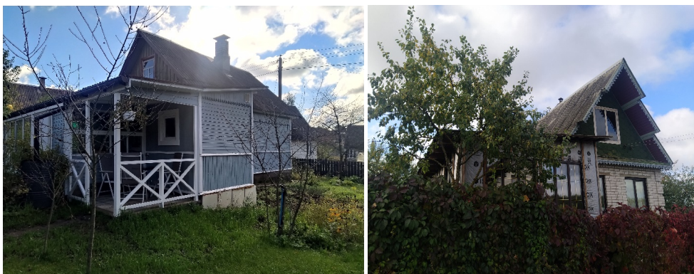
Рис. 4. Садовое товарищество «Узборье». Примеры пристройки новых объемов к существующим домам с возможностью круглогодичного использования ( в процессе строительства)
