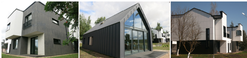
Рис. 1. Малоэтажные жилые дома в крупнопанельном исполнении с элементами сборного железобетона
