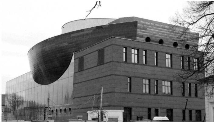
Rys. 3. Filharmonia Kaszubska, Wejherowo [ http://www.wck.org.pl/galeria/4/filharmonia-kaszubska.html ]
