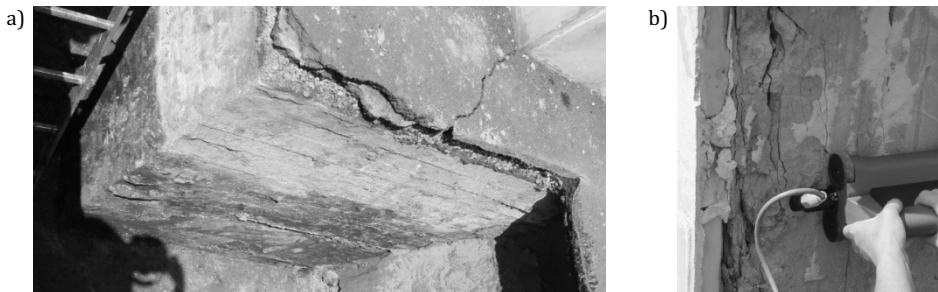
Rys. 1. a) Widok fragmentu fundamentu (fot. A. Kysiak); b) fragment odkrytej powierzchni betonowego bloku cokołu (fot. A. Kysiak)
