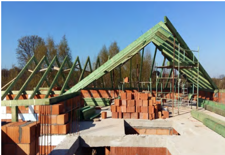
Rys. 2. Montaż więźby dachowej wykonanej z użyciem techniki CNC. Na fotografii widoczne podcięcia pod płatwie, gniazda dla krokwi [fot. autor]
