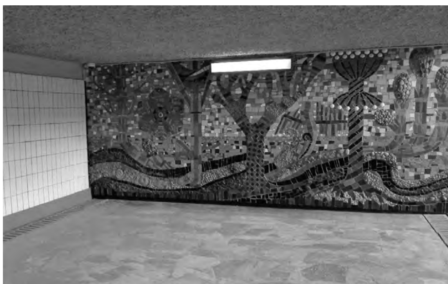
Rys. 2. Mozaika „Geneza” – praca wykonana przez artystę Tadeusza Drązkiewicza, fragment posadzki kamienniej, okładzina ściany z płytek elewacyjnych szklivionych i sufit z ozdobnym tynkiem kraterowanym
