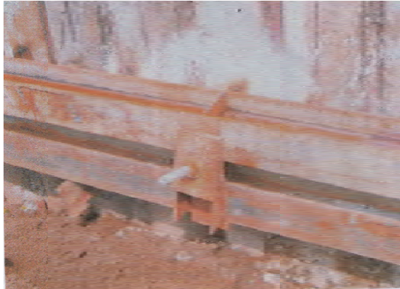
Rys. 1. Kotwa gruntowa [2]
