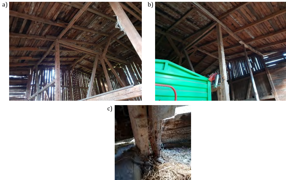
Rys. 2. Widok ustrojów nośnych
