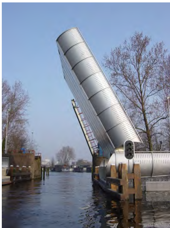
Rys. 7. Most Uiverbrug nad kanałem Riekenhaven w Amsterdamie (Holandia) [18]
