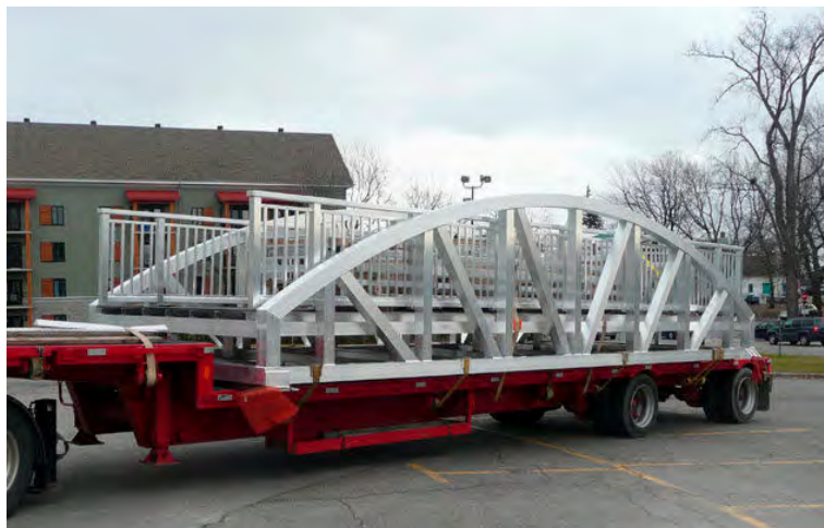
Rys. 8. Transport wykonanego w całości aluminiowego obiektu mostowego gotowego do montażu [19]
